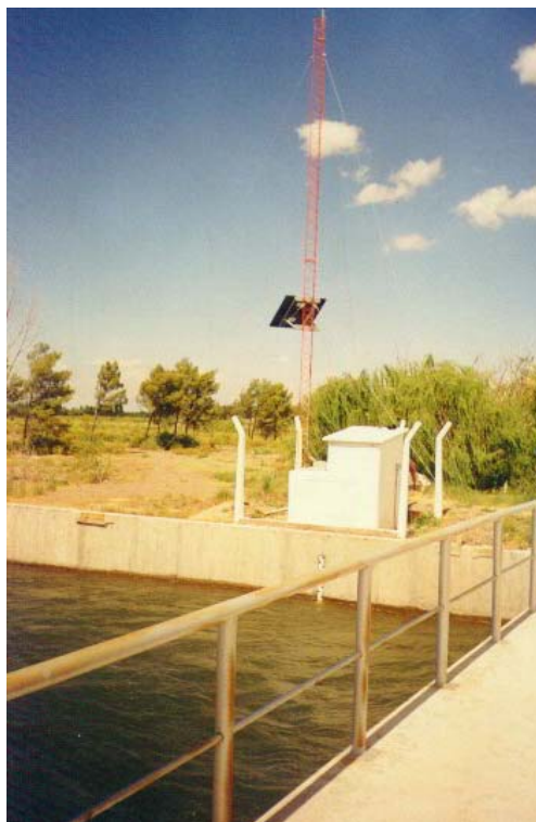
Figura II.31: Aforador telemétrico en canal que utiliza el efecto doppler
